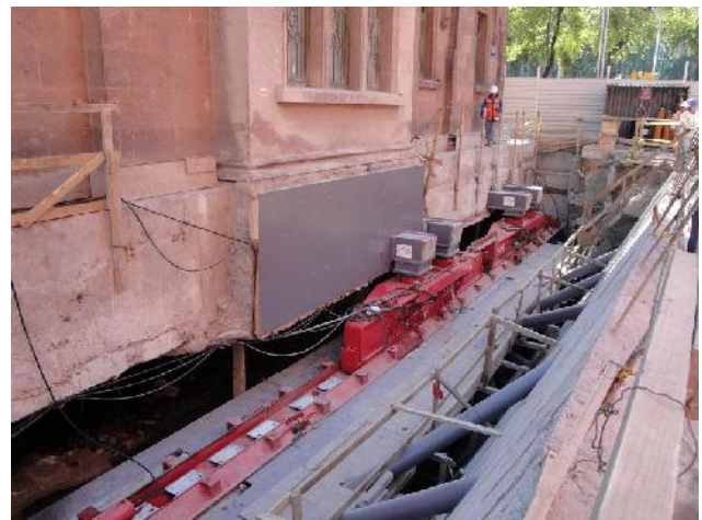
Figura 11. Sistema SKS1000 integrado por rieles modulares y patines de deslizamiento (skidshoes)
