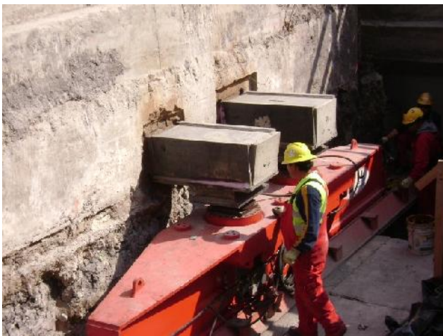
Figura 8. Detalle donde se observan los gatos hidráulicos (skidshoes) y las ménsulas empotradas en la losa de cimentación
