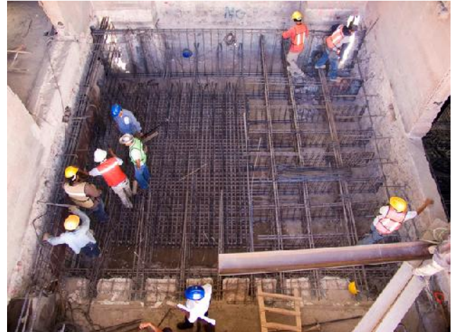
Figura 6. Construcción de losa nervada para recimentación
