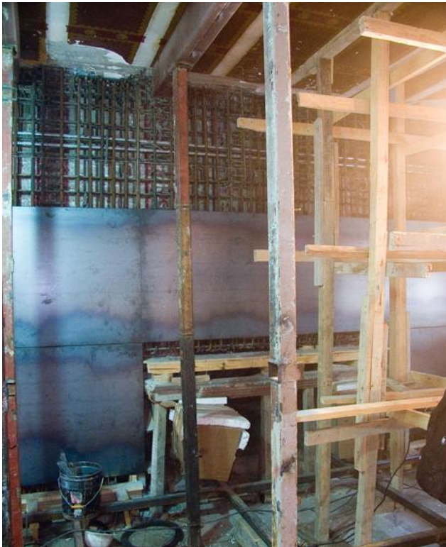
Figura 4. Reforzamiento de la casa con muro de concreto armado (Cortesía Fondo Hexa)
