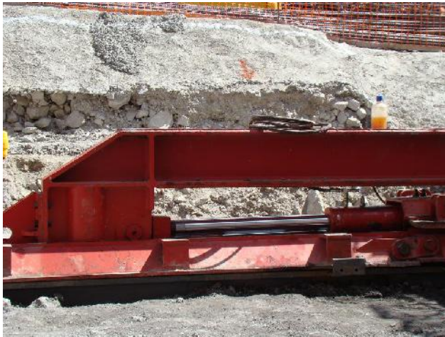
Figura 12. Detalle de uno de los gatos de empuje SS500
