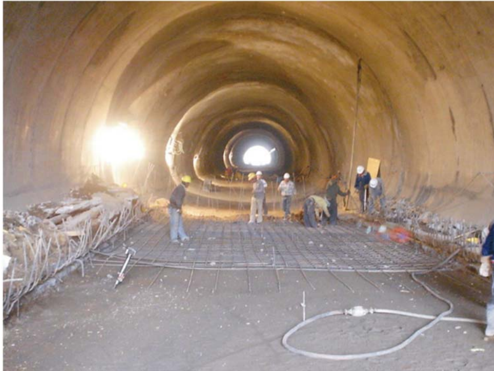
Fig. 7 Excavación y armado de la cubeta del túnel
