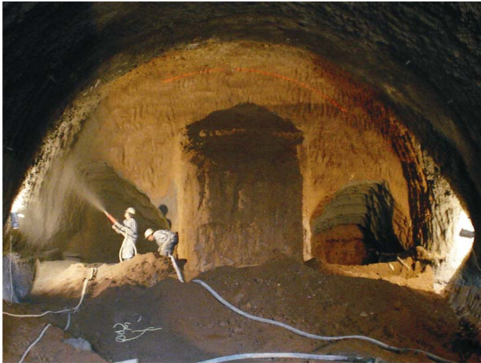
Fig. 6 Excavación del frente del túnel.
